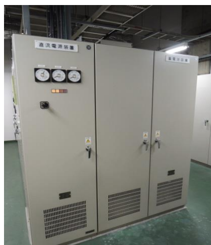
対象の直流電源装置
