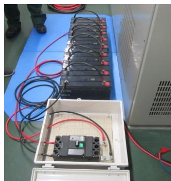
仮設電源を設置
